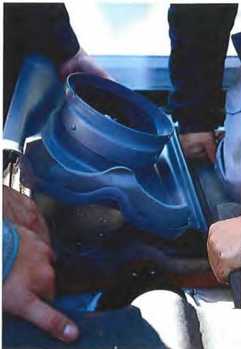
Miehet asentavat kattoon läpivientikauluksen, josta aurinkonesteputki johdetaan sisään.
