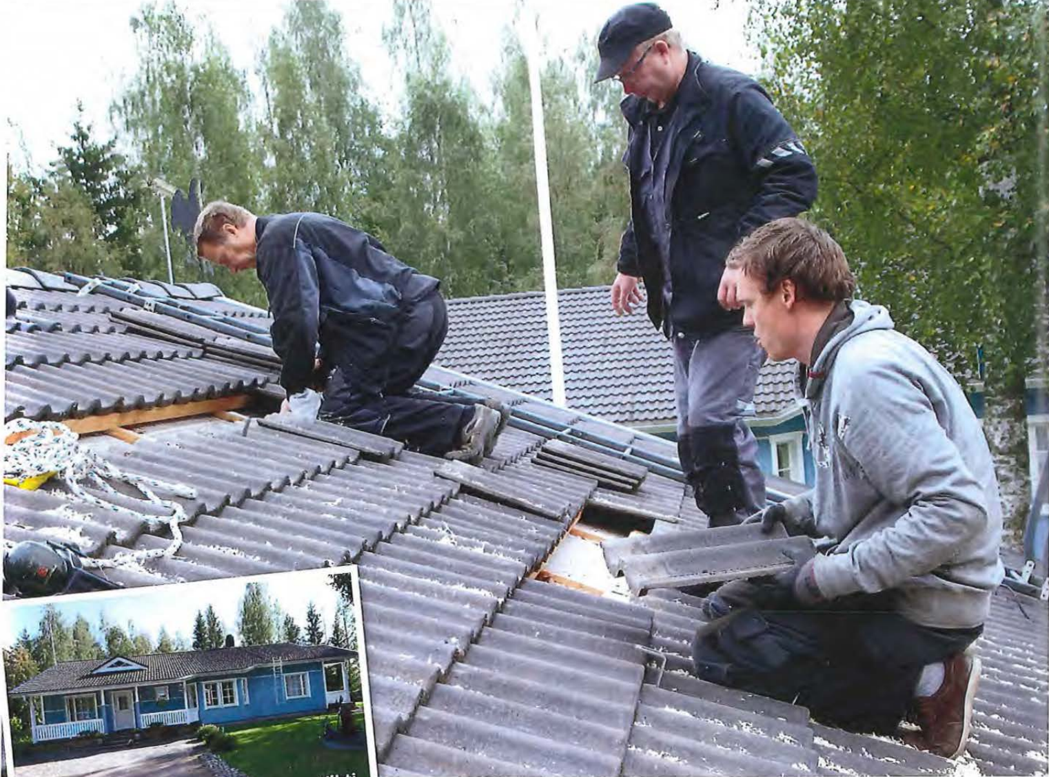
Asentajat purkavat ensin hieman tiilikattoa, jotta he pääsevät ruuvaamaan telineiden kiinnikkeet katon ruoteisiin. Kari Balk (keskellä) ohjaa asennustyötä.
