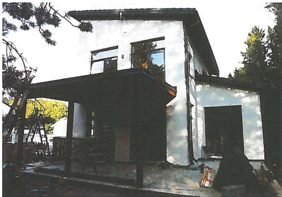
Talo alkaa olla sisätiloiltaan valmis, mutta ulkopuolella on vielä tekemistä. Talon päähän tulee pergola ja lasitettu parveke.
