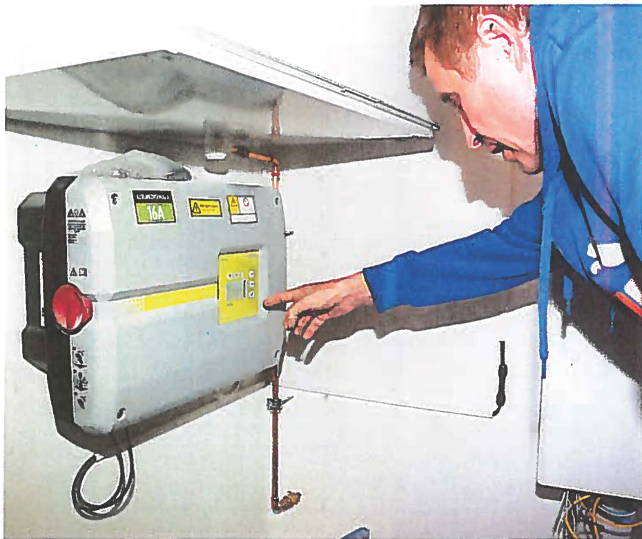
Aurinkosähkövoimala on talon teknisessä tilassa. – 340 wattia tulee parhaillaan, ja koko päivän tuotto on ollut 5,2 kWh. Tuotto alkoi elokuun lopun pilvisenä päivänä noin viiden aikaan aamulla ja päättyi noin kello 20:n aikaan.
