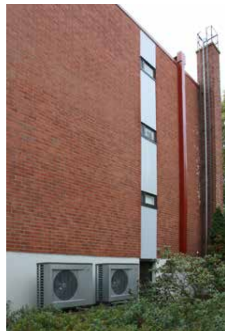
NIBEn ilma-vesilämpöpumput sijaitsevat lämmönjakotilan ulkopuolella.
