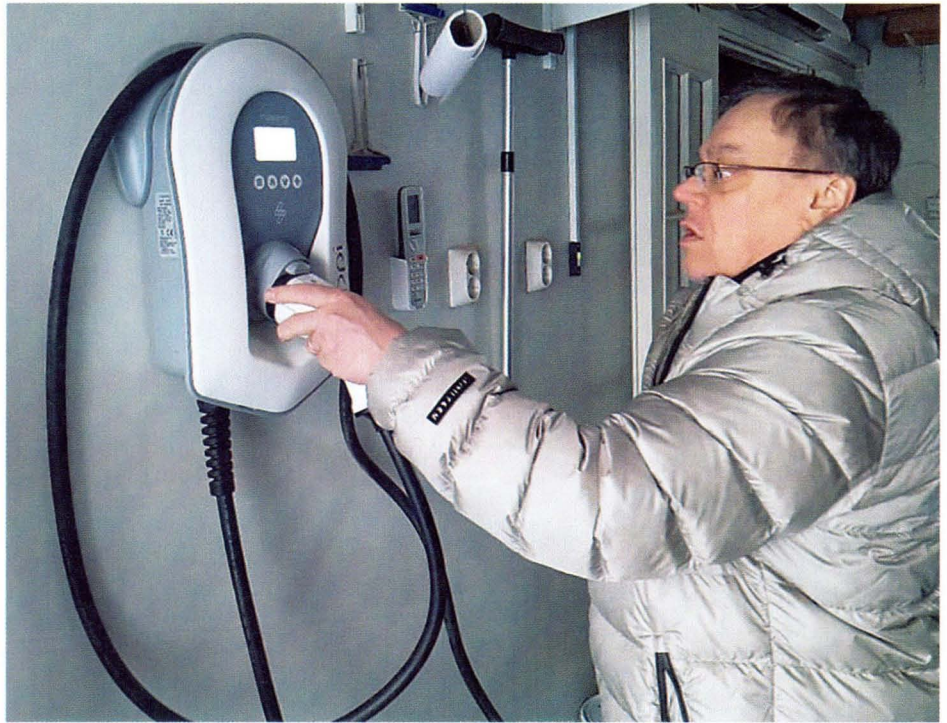
Autotalliinsa Tapio Tuomi rakennutti latauspisteen kahdelle sähköautolle. – Lähtökohtana on ladata autoa kotona ja käyttää julkisia latauspisteitä pidemmillä matkoilla, Tuomi kertoo.
