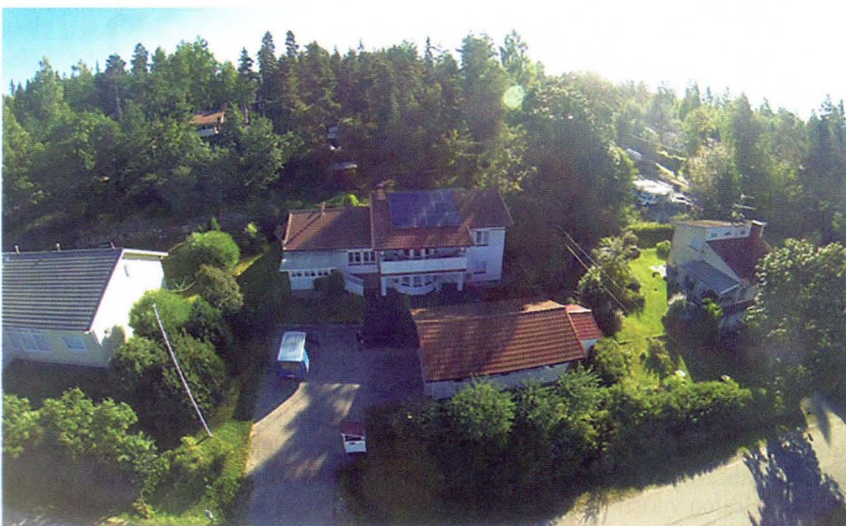
Tuomien 250-neliöisen talon katolle asennettiin vuonna 2014 aurinkopaneelit.
