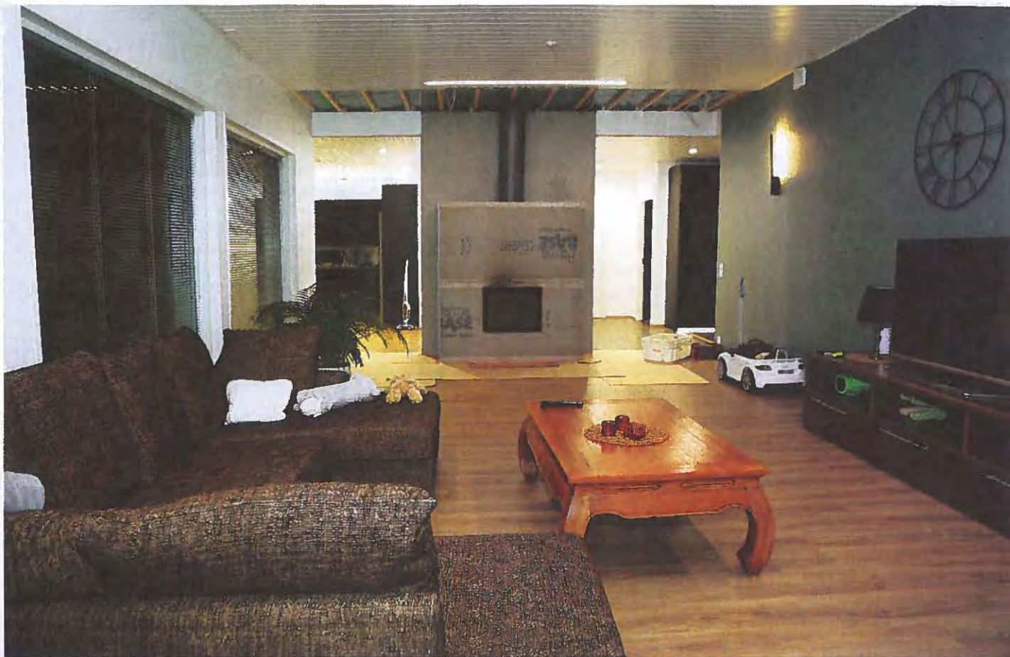
Olohuone on tilava ja valoisa. Vesitakan pinta odottaa vielä laatoitusta.
