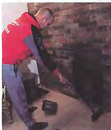
Saunan kiuas lämmitetään ulkopuolelta.
