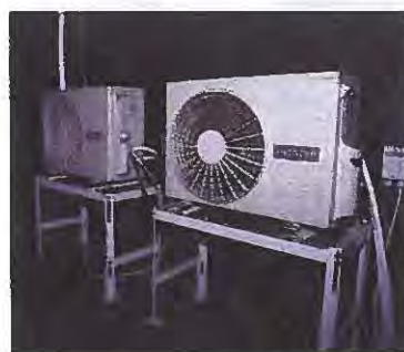
Hybridilämmitykseen kuuluu vesitakan ja vesikiukaan lisäksi vesi-ilmalämpöpumppu.
