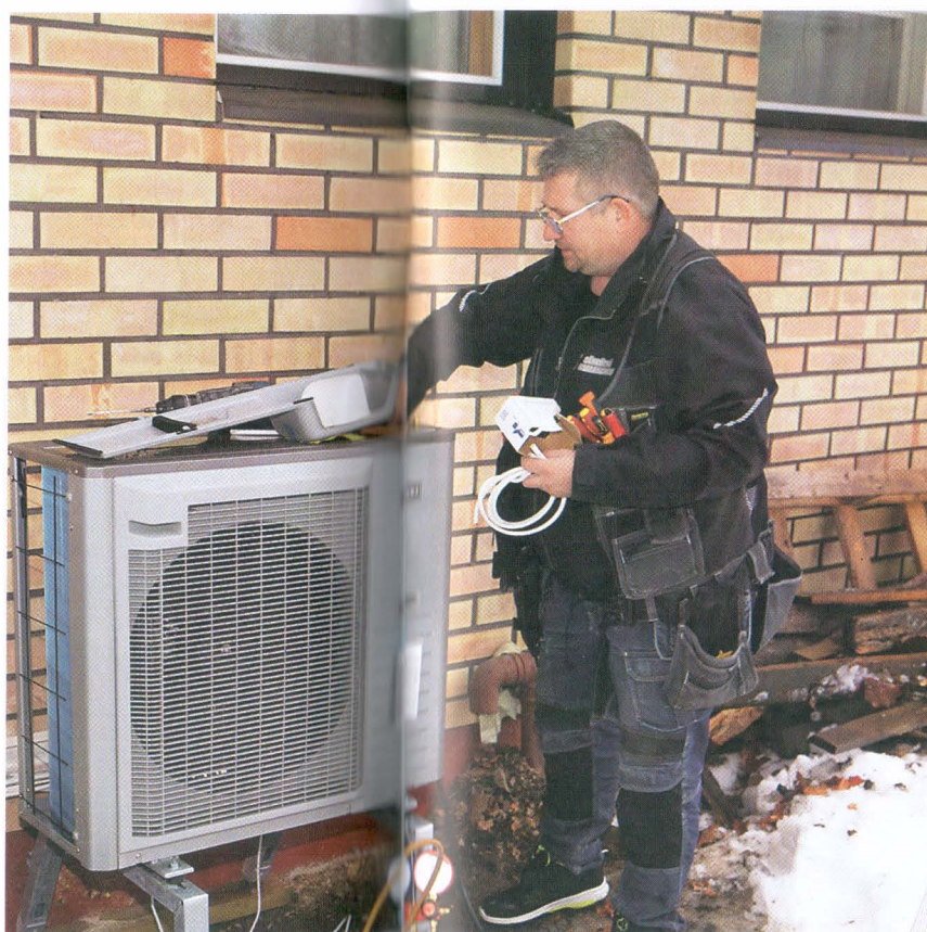
Ilma-lämpöpumpun ulko-osa sijoitettiin talon seinustalle saunan ikkunan alle. Viimeistelytyöissä Marko Kaarakainen. Kylmäaineputket kulkevat seinän läpi saunaan ja siitä edelleen
