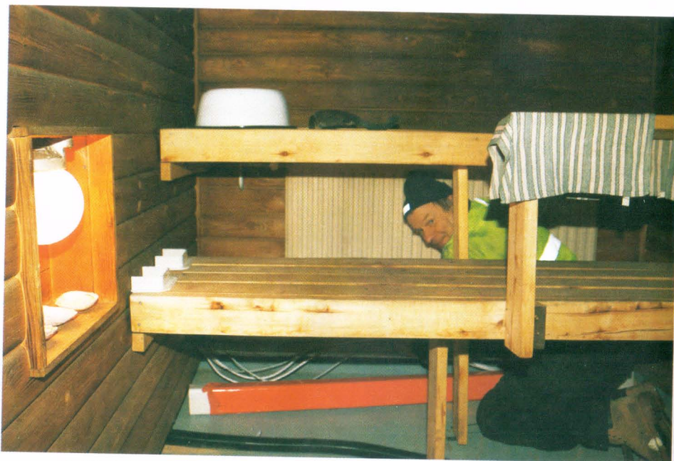
Kari Sariola asensi kylmäaineputket kulkemaan suojakotelossa saunan lautaiden alta.
