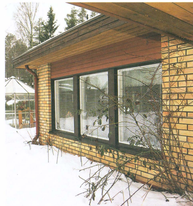
1974 valmistuneessa talossa on asumispinta-alaa 119 neliötä.
