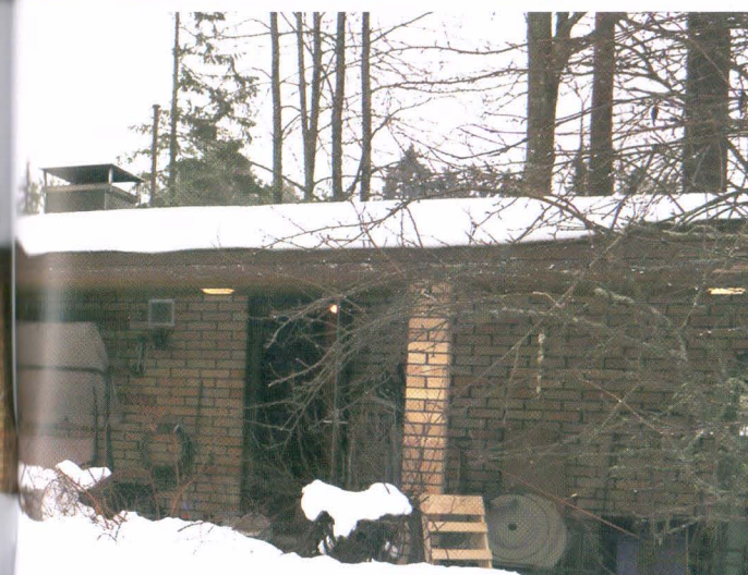
Ilma-lämpöpumpun ulko-osa sijoitettiin talon seinustalle saunan ikkunan alle. Viimeistelytyöissä Marko Kaarakainen. Kylmäaineputket kulkevat seinän läpi saunaan ja siitä edelleen
