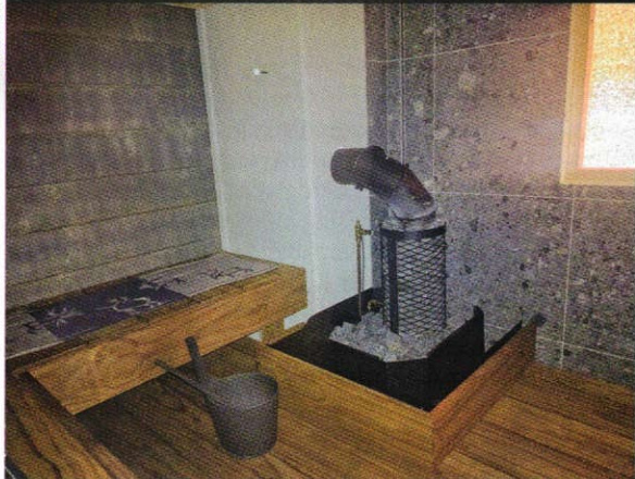
➡ Vesikiertokiukaan luukku on takkahuoneen puolella. Kiuas sytytetään ja puuta lisätään takkahuoneessa. Saunassa ei ole lainkaan kiukaan luukkuja.
